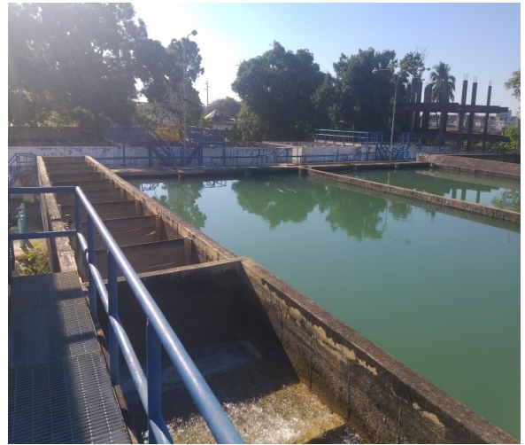
Figura 2. Floculador vertical. Planta potabilizadora de agua de la ciudad de Barinas. Elaboración propia (2020).
