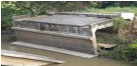
Figura 2. Estribo del Puente.
